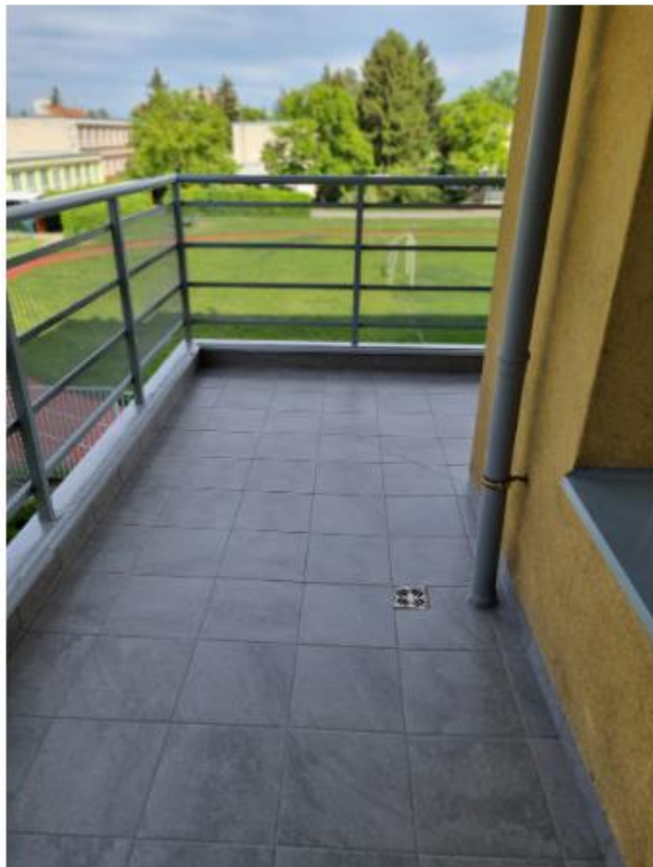
Renovovaný balkon (Zdroj: Bralep)
