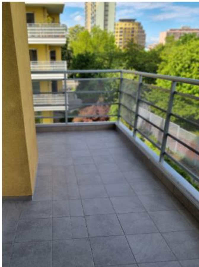
Nalepení dlažby pomocí flexibilního lepidla. Spárování spárovací hmotou (Zdroj: Bralep)
