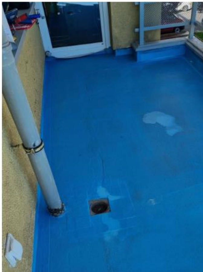
Dvousložková hydroizolace do exteriéru se nanáší ve dvou na sebe kolmých vrstvách (Zdroj: Bralep)
